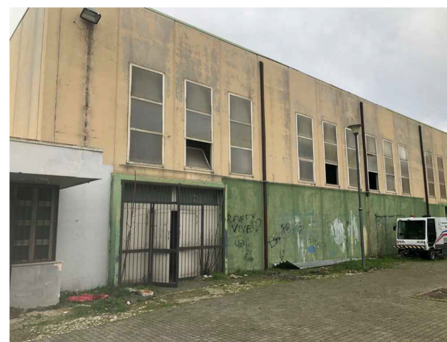
FOTO STATO DI FATTO _INGRESSO
